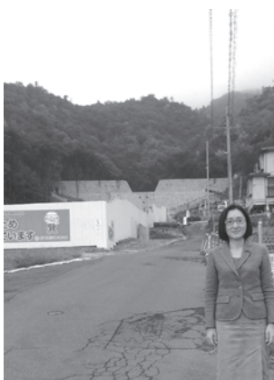
広島市土砂災害現場。砂防ダムを建設中
