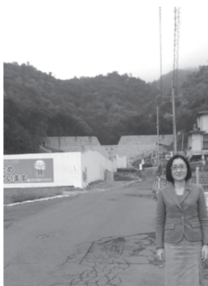
広島市土砂災害現場。砂防ダムを建設中
