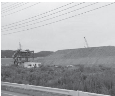
左側の建物が南三陸町防災対策庁舎ですが、その建物の高さ(12m)まで土地のかさ上げを行います。
